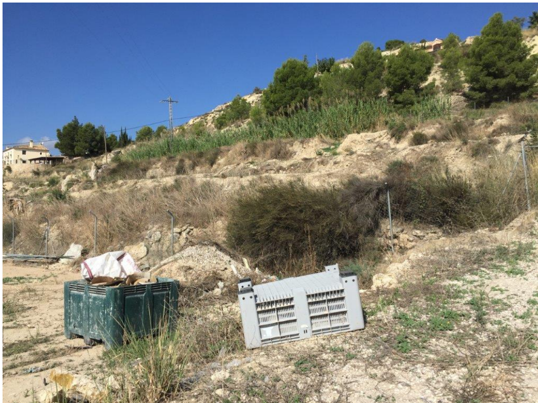
Fotografía del estado actual de la zona de actuación
