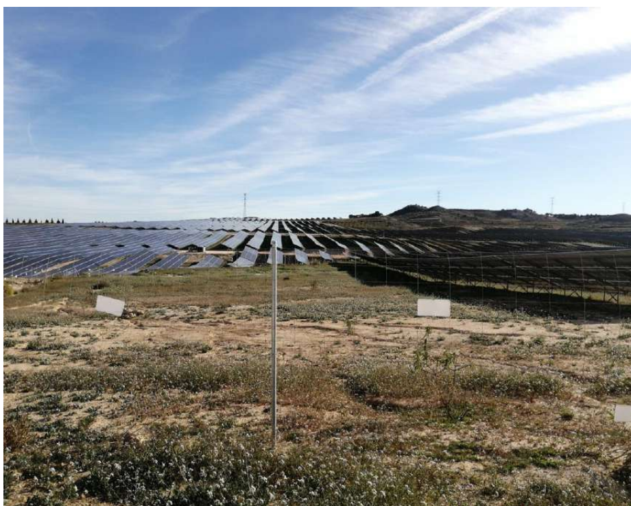
Fig. Vista de uno de los subparques de la planta solar Mula de 450 MW. Fuente: Ideas Medioambientales.
