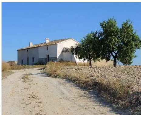
Fig. Visual desde la Casa del Abogao y edificación.
