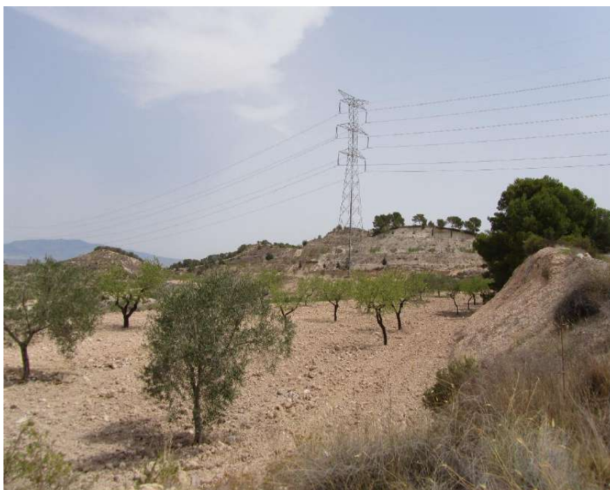
Fig. Vista de la Línea de Alta Tensión desde la zona Sur de la actuación
