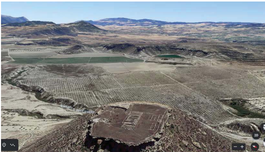
Figura 3. Vista aérea de la zona de actuación hacia el S-SW desde el Castillo de Alcalá. Fuente: Google Earth.
