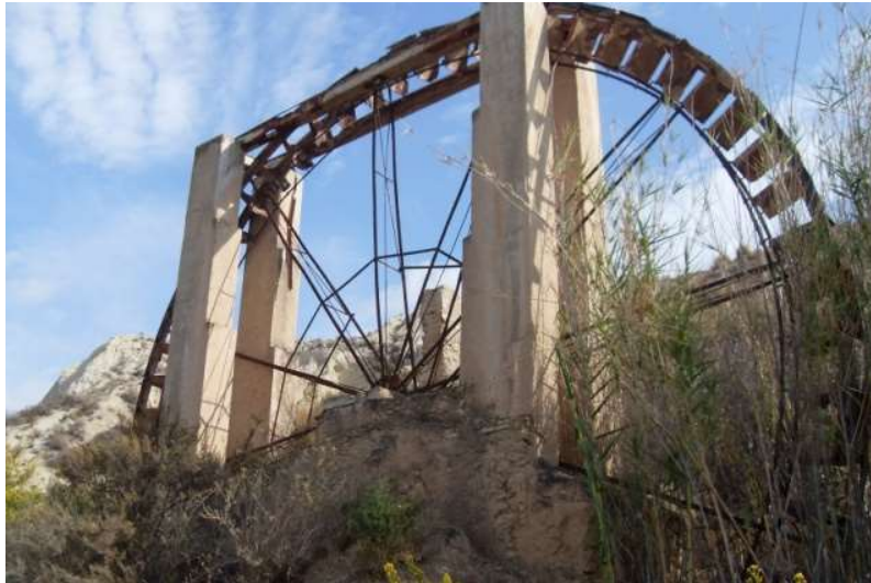
Figura 17. Noria de Velasco, situada en el regadío tradicional de la margen izquierda del río Mula, en la conocida como Huerta de Cara
