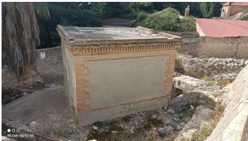
Figura 9. Edificio del partidor de la Piñuela, que presenta una clara similitud a las obras coetáneas de la vía férrea de Murcia a Caravaca de la Cruz
