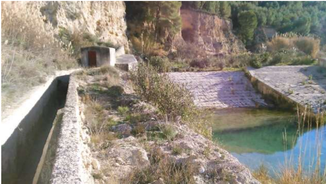
Figura 14. Azud de El Gallardo; obra de mampostería, levantada en numerosas ocasiones en este lugar. La actual, si bien requirió algunas reparaciones, se terminó a finales de siglo XIX (González, 1991)
