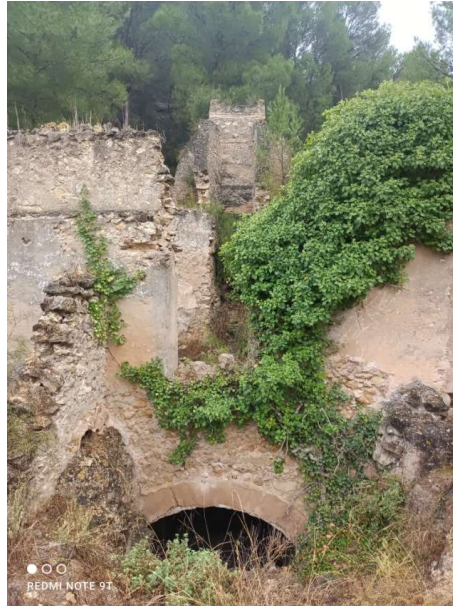
Figura 12. Estado del salto de agua y edificio de la antigua fábrica de la Luz
