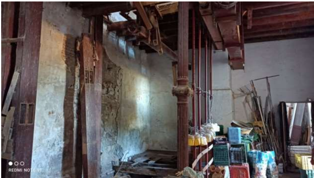
Figura 1. Interior del edificio preindustrial situado en la finca El Martinete. Funcionó para producir cobre y, posteriormente, para triturar el cereal, sumándose así al segundo molino hidráulico que trabajó en esta hacienda
