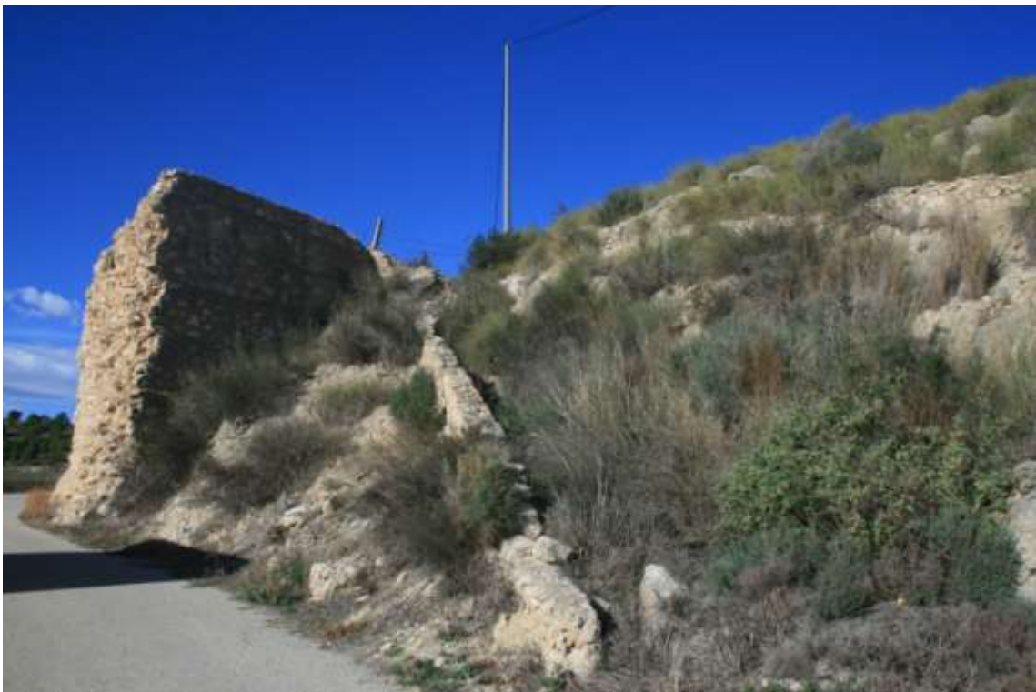
Imagen 7. Salto de agua no funcional en la Acequia Mayor, situado por encima del molino de Felipe. La caída de agua dio servicio a una antigua fábrica que generaba luz eléctrica.
