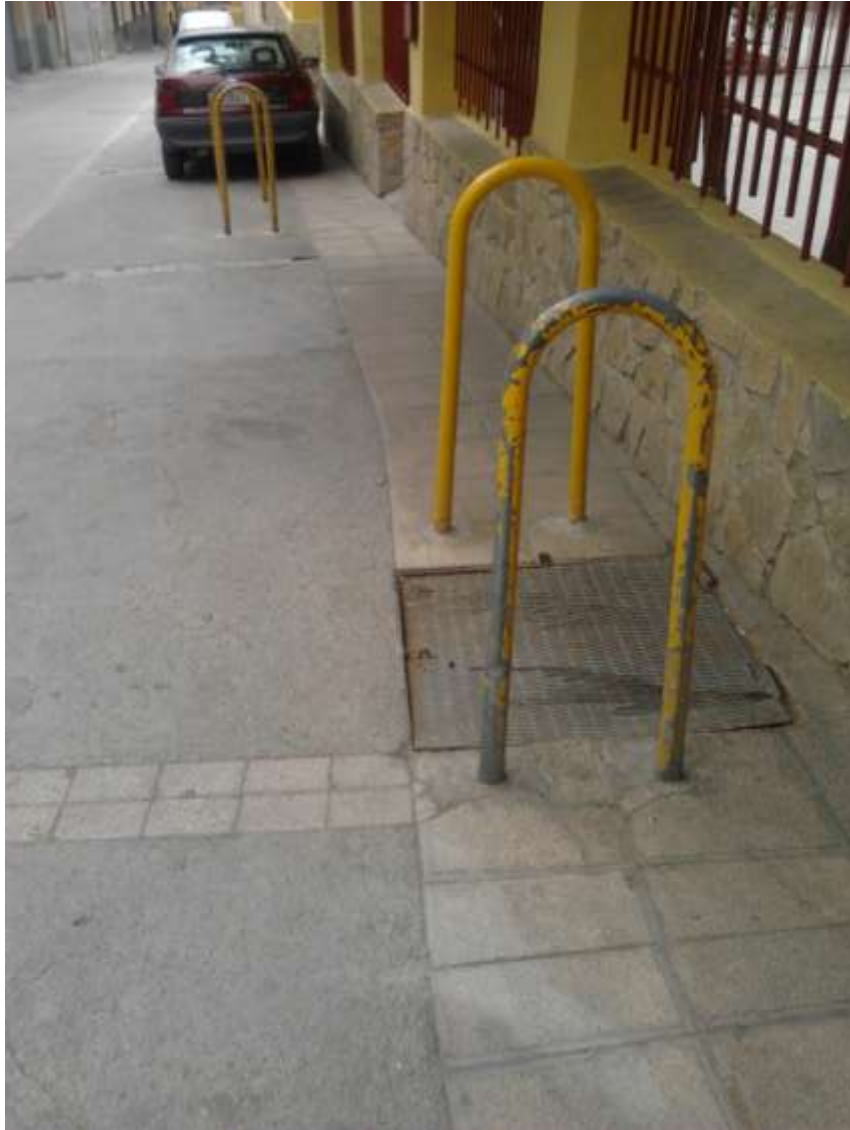
Imagen 1. Localización del antiguo partididor situado en la Calle Jardín. Fue remodelado con la conexión del Canal Bajo del embalse de La Cierva, siguiendo el modelo de sifón. Todavía se utiliza para dar servicio a algunos regantes, que conservan el riego a manta.
