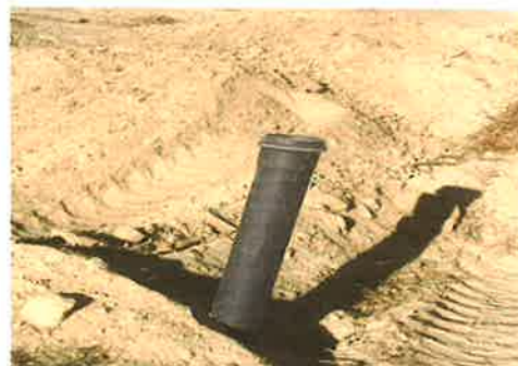
DETECCION DE FUGAS
