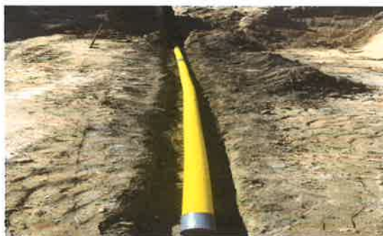
DETECCION DE FUGAS
